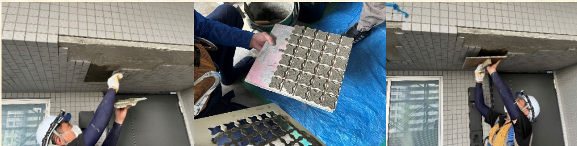
弾性ボンド貼下地に張り付けモルタル塗布、専用のマスクにて新規タイル面にも貼り付けモルタルを塗布
