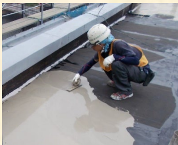
勾配レベラー下地調整
